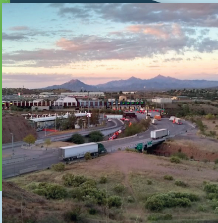
PUENTE INTERNACIONAL NOGALES UNO
